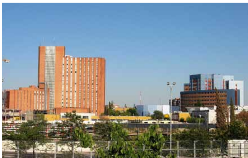
Vista del Hospital 12 de Octubre de Madrid. (Wikipedia ORG)
