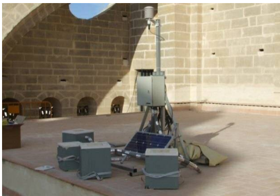
Instalación de la estación meteorológica y sensores de medida de flujos de energía superficial (sensores de flujo de calor) en la Iglesia de El Salvador de Sevilla
